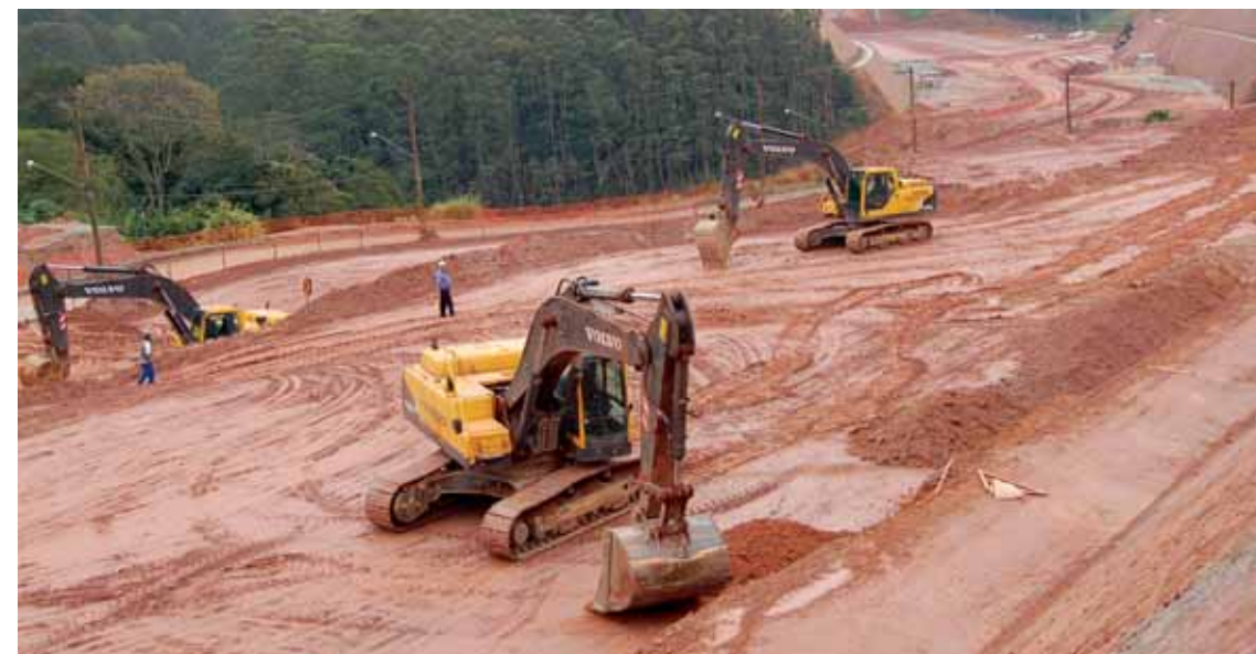
Impegnate 24ore al giorno, su tre turni, queste macchine stanno movimentando oltre 26.000m 3 di terreno al giorno.
